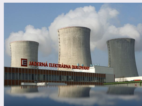
Атомная электростанция, г. Дукованы
